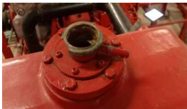
รูปที่ 13 ตรวจสอบเช็คระดับหม้อน้ำ
