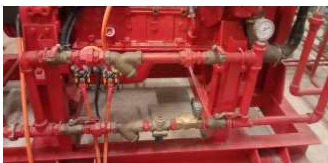
รูปที่ 18 ตรวจเช็คตำแหน่งวาล์ว น้ำ เปิด/ปิด
