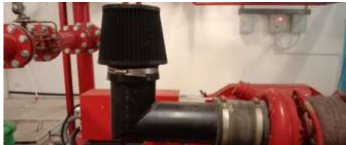
รูปที่ 11 ตรวจสอบเช็คกรองอากาศ เครื่องยนต์
